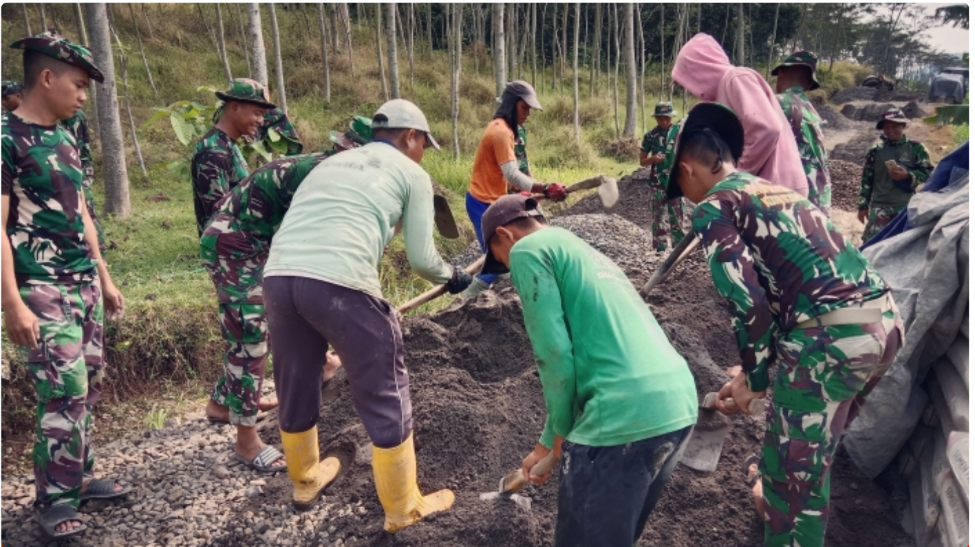
Anggota Satgas TMMD Reguler Ke-115 Kodim 0719/Jepara Genjot Terus Pengecoran Jalan di Ujungwatu, Kecamatan Donorojo, Kabupaten Jepara, Jawa Tengah.
